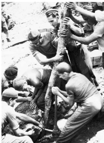
Saleziánski klerici pri práci na výstavbe priehtady.
